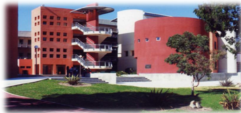
Figura 2 Instalaciones de la FCA Fuente: (UABC, 2011).
