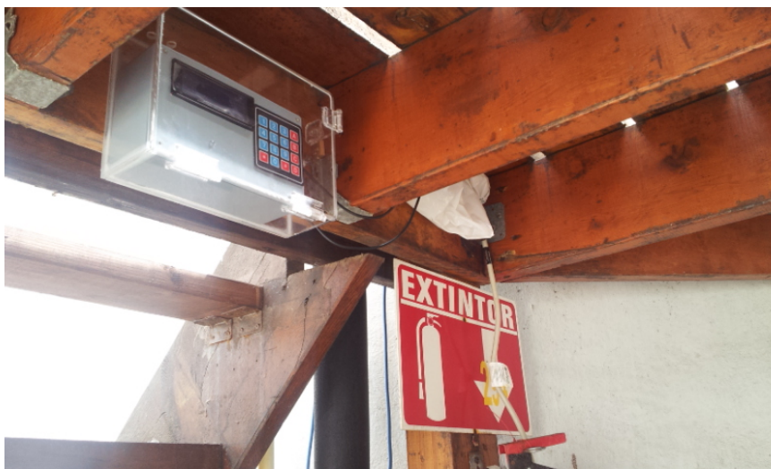
Figura 62: Prototipo del medidor de temperatura y oxígeno instalado en la UBP de la UABC.
