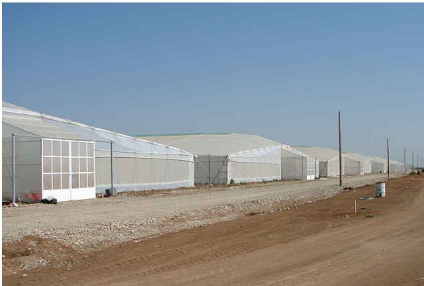
Figura 7. Invernadero tipo asimétrico.
