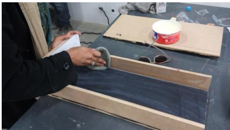
Figura 2.14. Aplicación de desmoldante en caja de madera.
