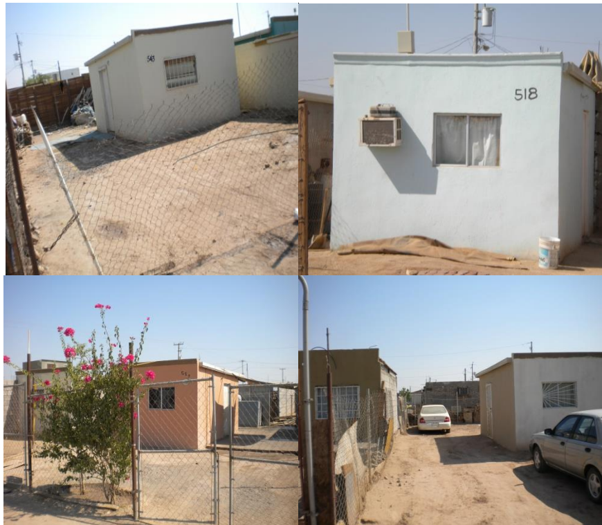
Figura 4. Viviendas sin ampliaciones.
