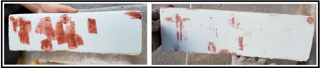
Figura 4.32. Uso de pasta de secado rápido perfil con pasta resanadora, a) aplicación de pasta, b) pasta pulida.
