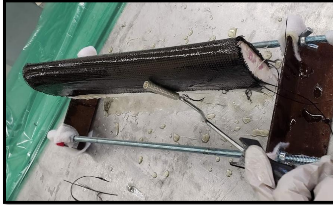
Figura 4.40. Distribución de resina epóxica con rodillo para laminados en perfil GOE777-IL.
