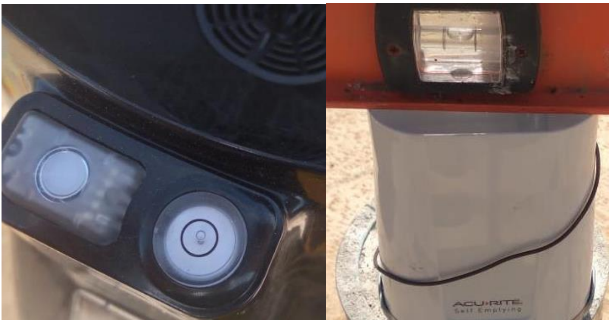
Figura 42. Nivelación de equipos de monitoreo en el montaje
