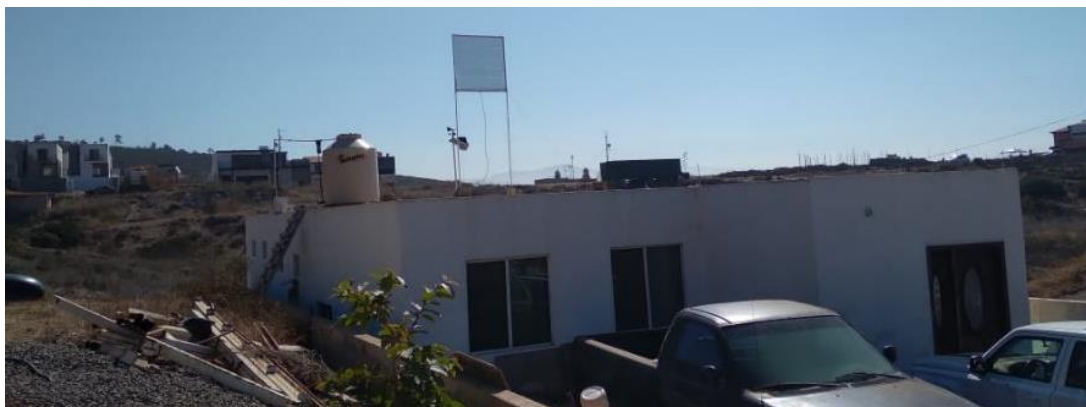
Figura 45. Montaje final del dispositivo en azotea de vivienda Pedregal Playitas
