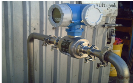
Figura 13. Instalación de medidor electromagnético en tubería.
