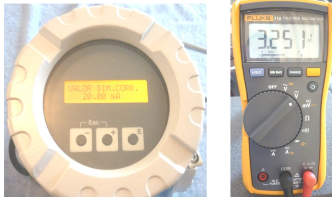
Figura 45. Prueba de medición corriente – voltaje.
