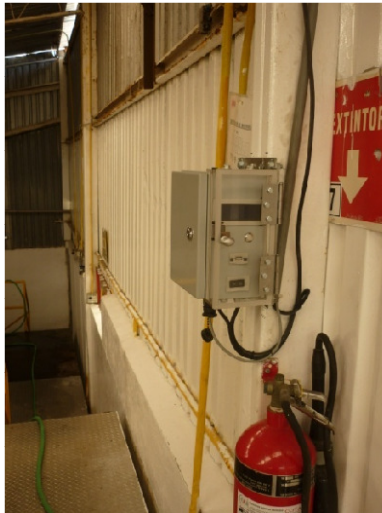
Figura 86. Instalación de caja metálica en la pared.
