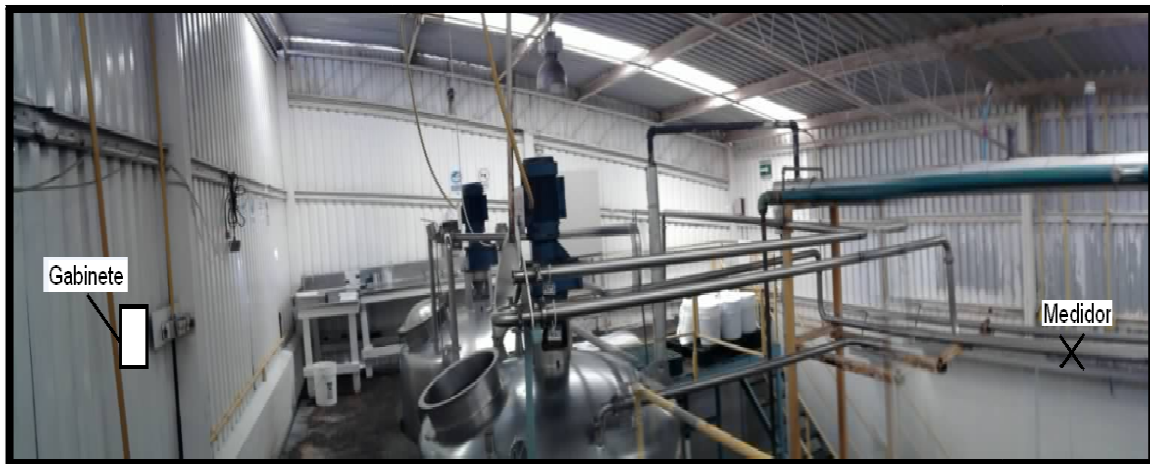
Figura 111. Sitio de instalación del gabinete.
