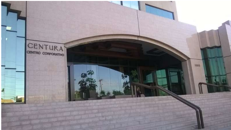
Figura 19. Vista frontal edificio Centura
