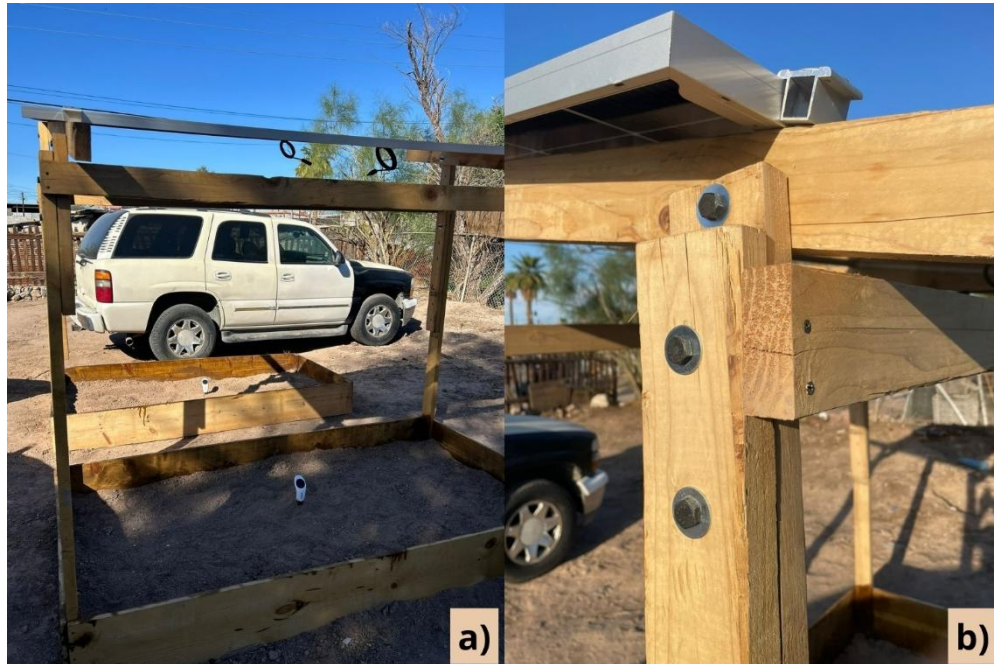
Figura 61. a) huerto agrovoltaico instalado; b) uniones de la estructura.
