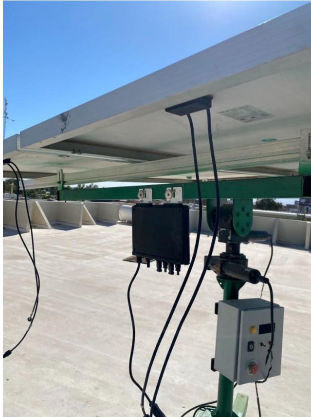
Figura 30. Instalación del inversor de corriente en el pilotaje experimental.
