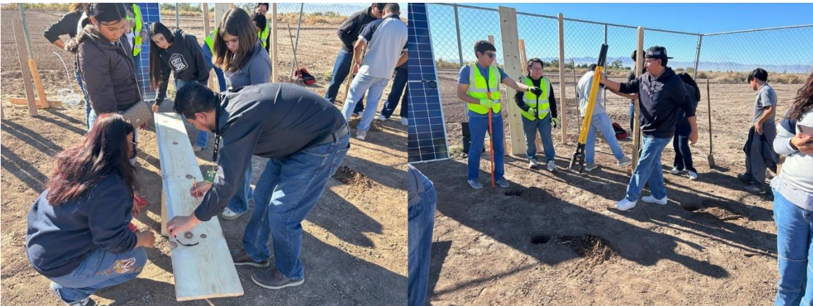
Figura 66. Proceso de instalación junto a estudiantes de CBTA #328.
