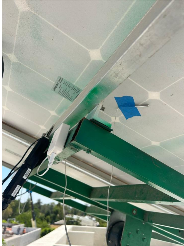
Figura 31. Instalación de los sensores de temperatura en el pilotaje experimental.
