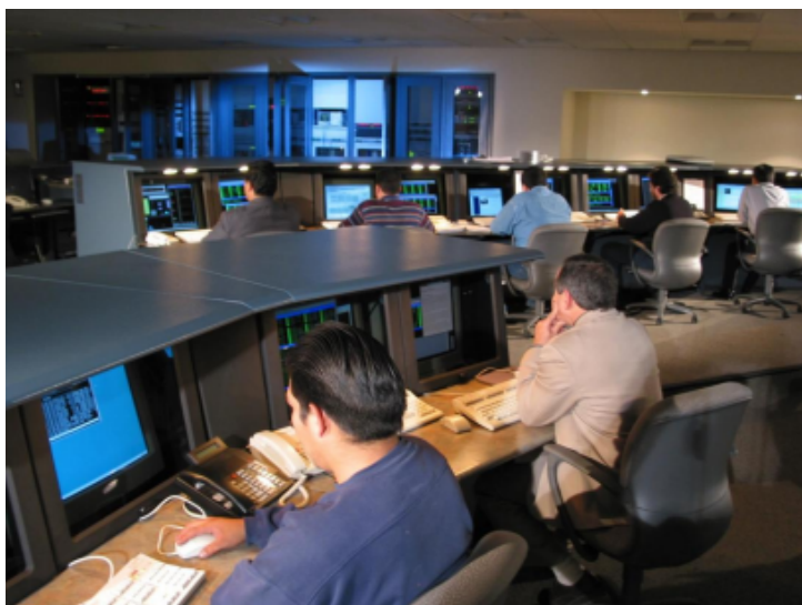
Figura 46: Centro de control satelital del SATMEX.
