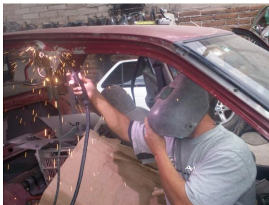
Figura 4.11 Operación de soldado, con EPP en malas condiciones y con un cartón como protección de la alfombra del automóvil
