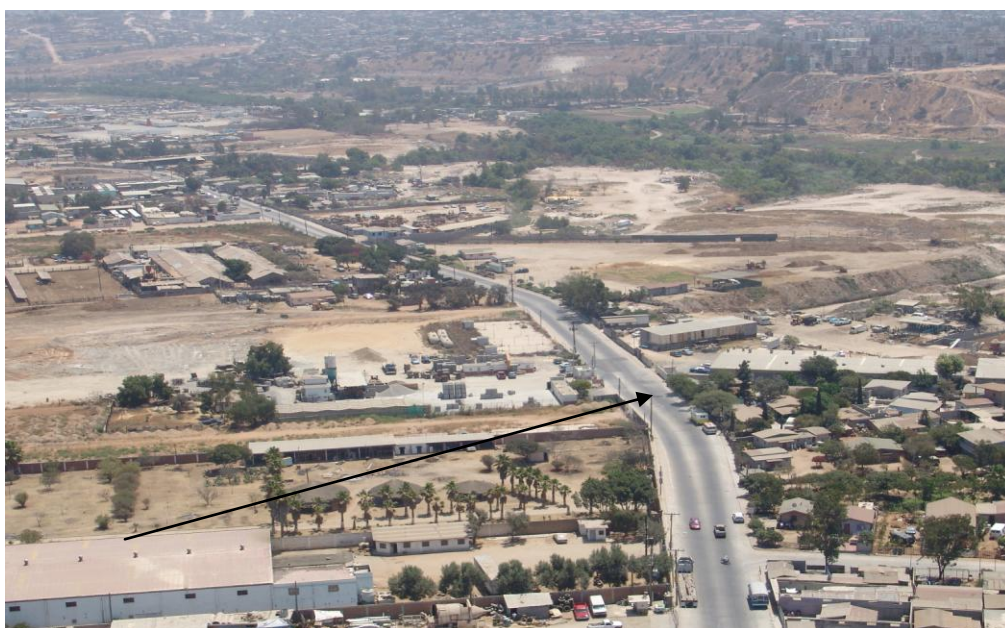
Foto 5: La avenida José Murúa una de las principales vialidades en la zona (vialidad de segundo orden).
