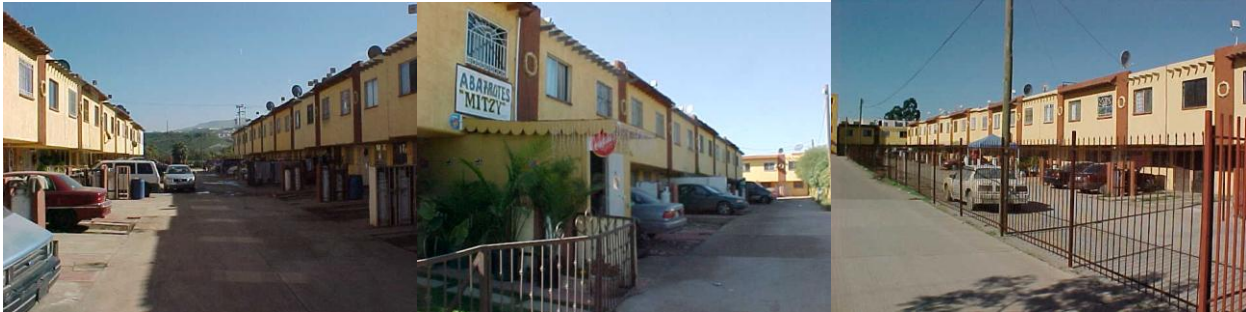
Foto 7 : Areas Comunes del conjunto habitacional Riberas del Alamar Condominio Horizontal (caso de estudio).
