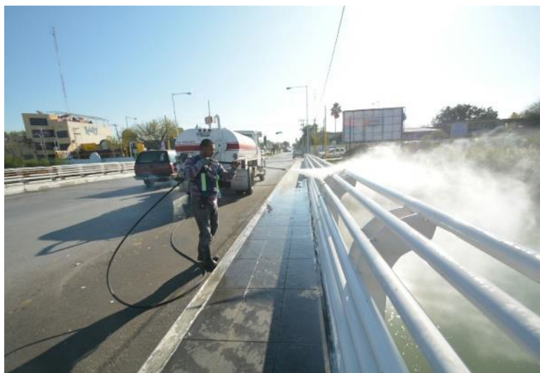
Figura 4.8: Limpieza en parapetos.
