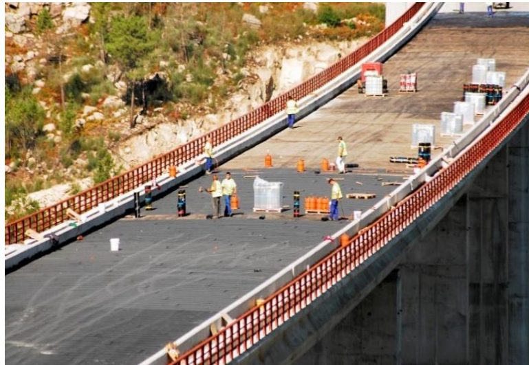
Figura 4.13: Rencarpetado de superficie de rodadura.
