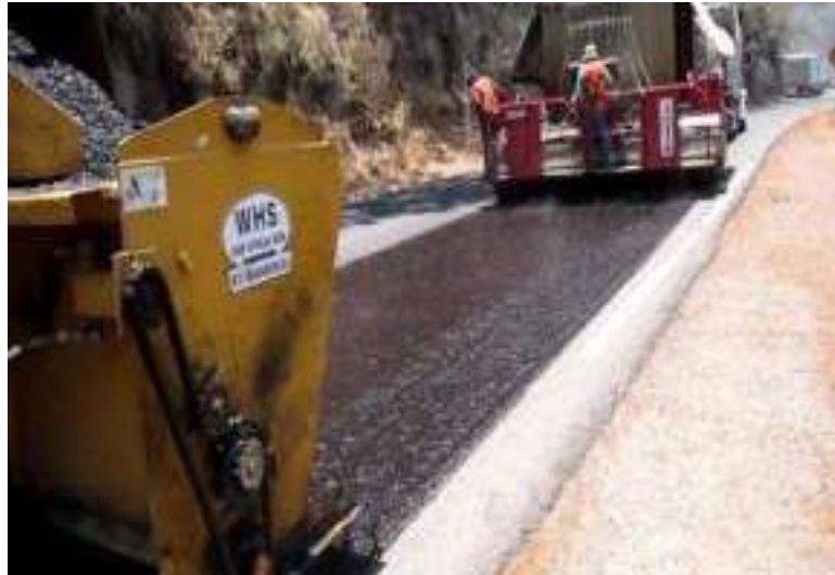
Figura 4.16: Renivelación de accesos.
