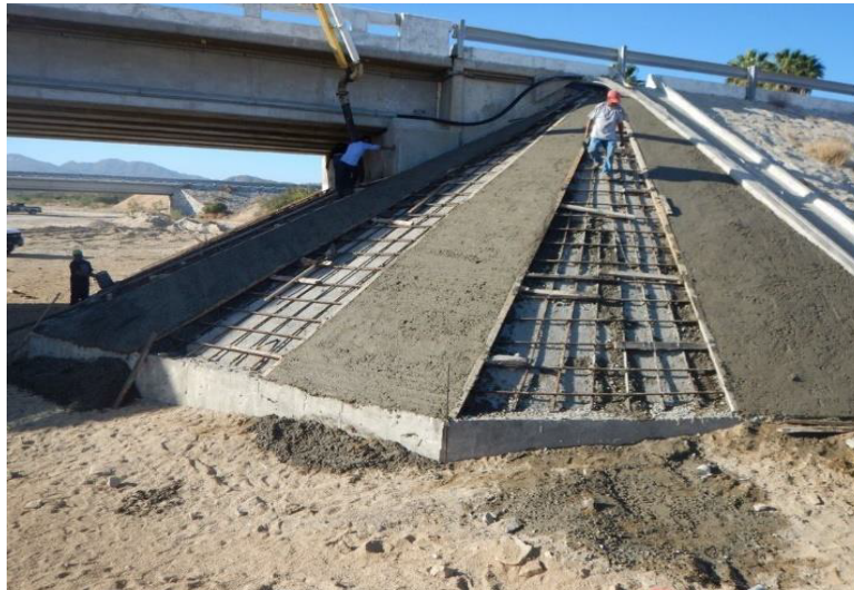
Figura 4.15: Construcción de conos de derrame.
