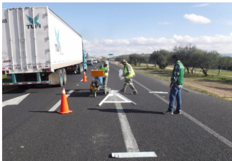
Figura 4.12: Reposición de marcas en el pavimento.
