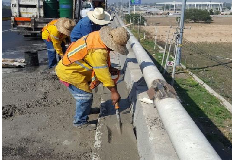
Figura 4.14: Reparación de guarniciones y banquetas.
