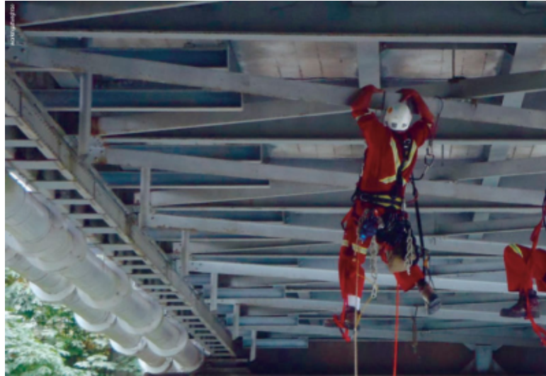
Figura 4.3: Inspección visual debajo de un puente.
