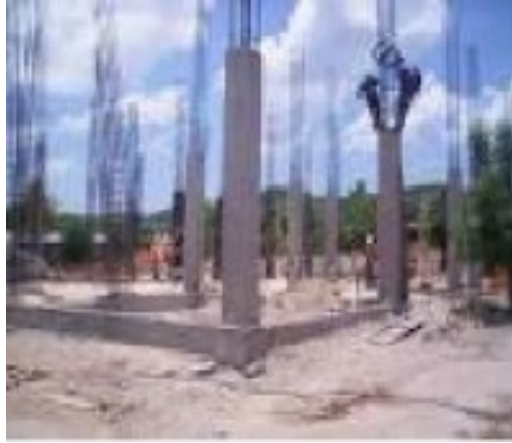
Figura 4.5: Estructura de columnas.
