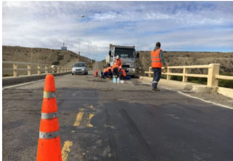
Figura 4.7: Trabajos en la superficie de rodadura.
