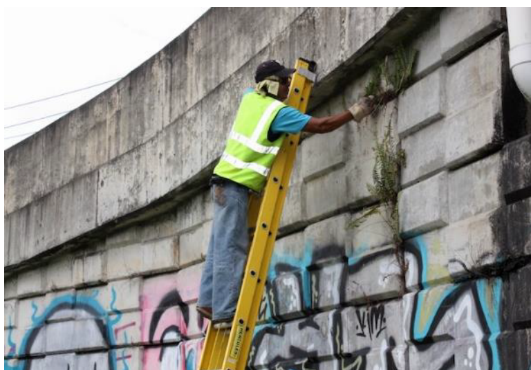
Figura 4.9: Limpieza de juntas de muros de tierra armada.
