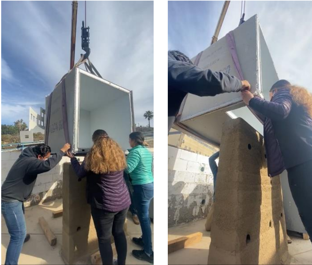
Figura 38. Ambos. Acoplamiento de los módulos con muros tapial.
