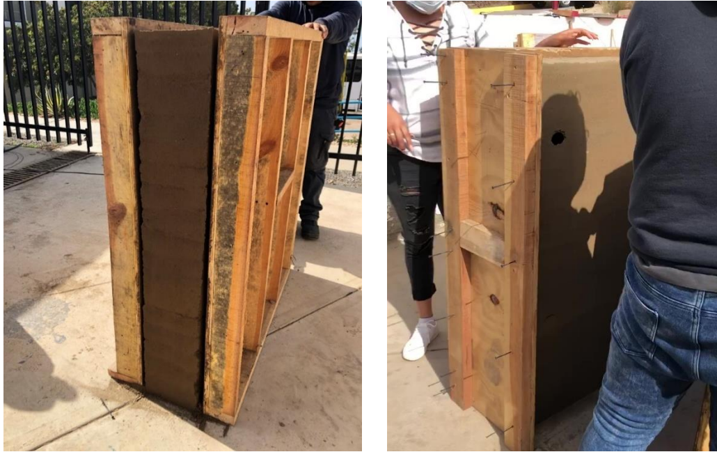
Figura 34. Ambos . Descimbrado del muro tapial. Fuente: Elaboración propia.
