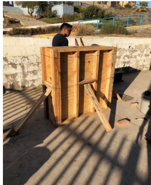
Figura 31. Izquierda. aplicación de desmoldante.
