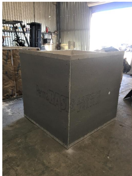
Figura 20. Instalación de paneles de cemento. Fuente: Elaboración propia.
