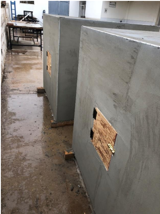
Figura 22. Compuerta cuadrada de madera y poliestireno. Fuente: Elaboración propia.
