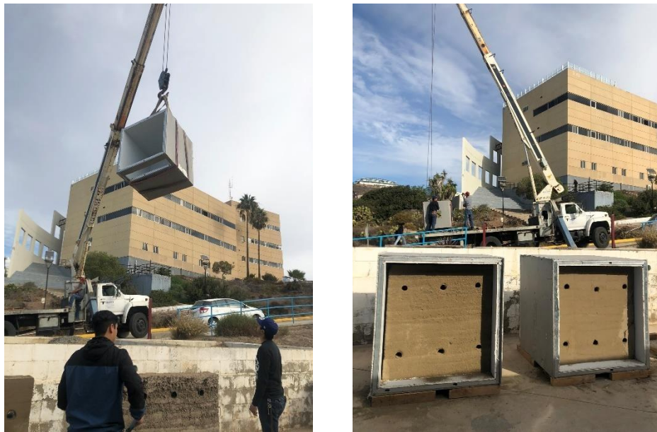
Figura 36. Izquierda. Traslado y maniobra. Derecha. Acoplamiento de módulos con muros tapial.
