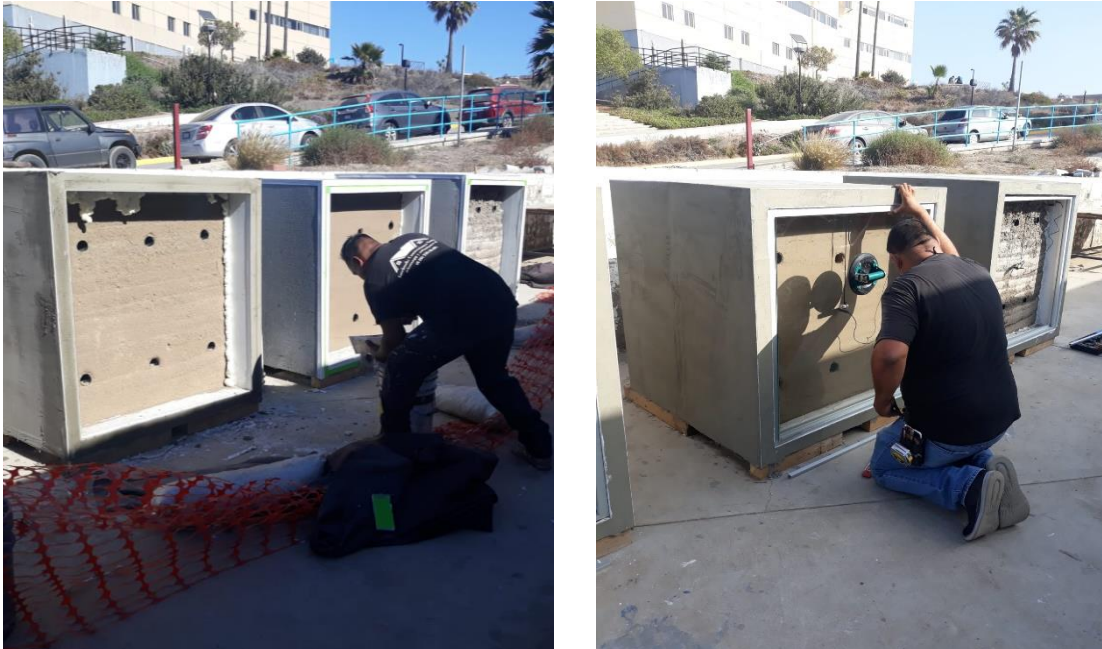
Figura 39. Izquierda. Aplicación de acabados finales. Derecha. Instalación de ventana fija. Fuente: Elaboración propia.
