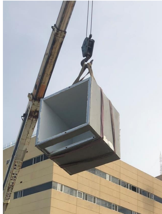
Figura 21. Vano en la parte inferior del módulo. Fuente: Elaboración propia.
