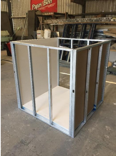
Figura 19. Instalación de panel de yeso. Fuente: Elaboración propia.
