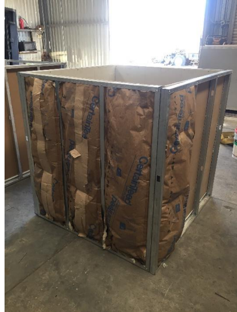
Figura 18. Instalación de fibra de vidrio. Fuente: Elaboración propia.
