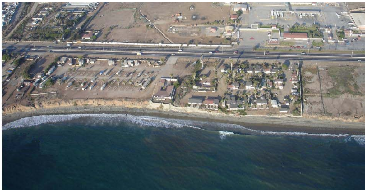
Figura 36. Franja costera frente a la refinería de Pemex. Se muestra que casi no hay muros de protección en esa área (Modificada de Proyecto de Desarrollo del Puerto de El Sauzal, Baja California, 2010).
