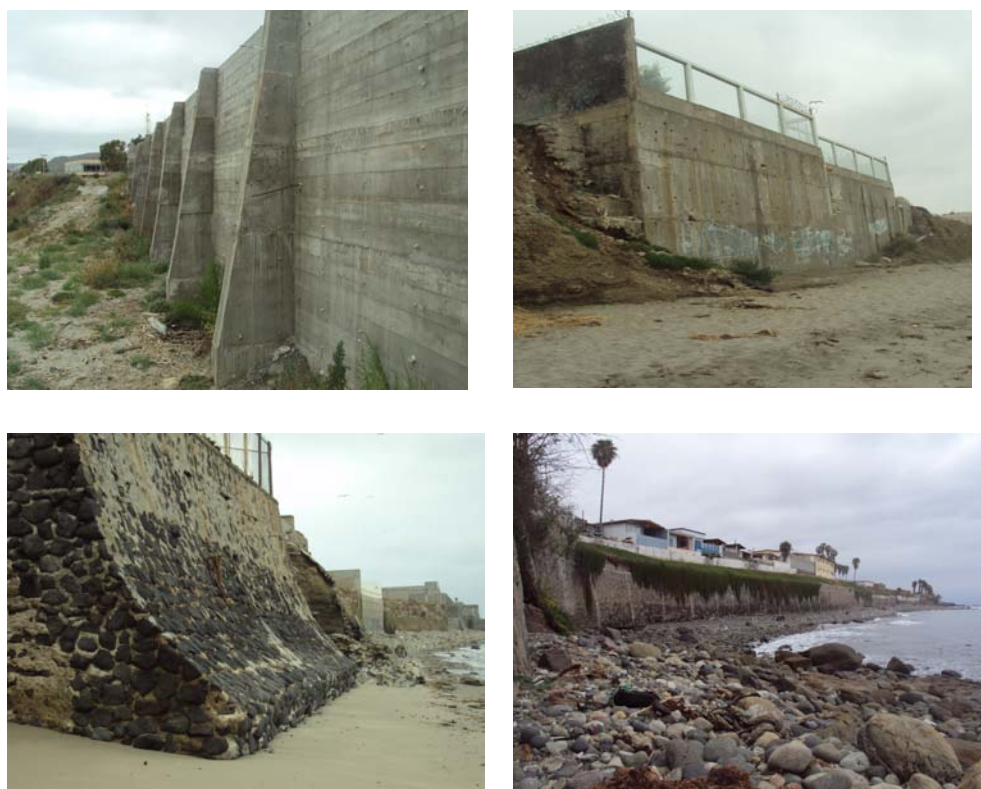
Figura 21. Diferentes tipos de muros localizados en la costa del Sauzal.
