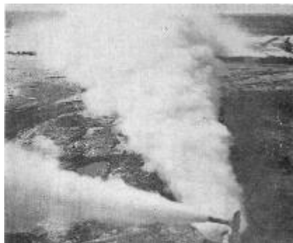
Imagen 6.14. Salida del vapor a través de ducto en la planta Geotérmica 222 .
