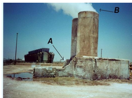
Imágenes 6.7 y 6.8 Vista del silenciador y Salidas del Separador (A , B)
