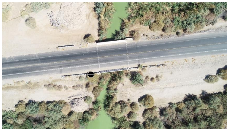
Figura 10. Ubicación del BN en el Puente de la carretera estatal #4
