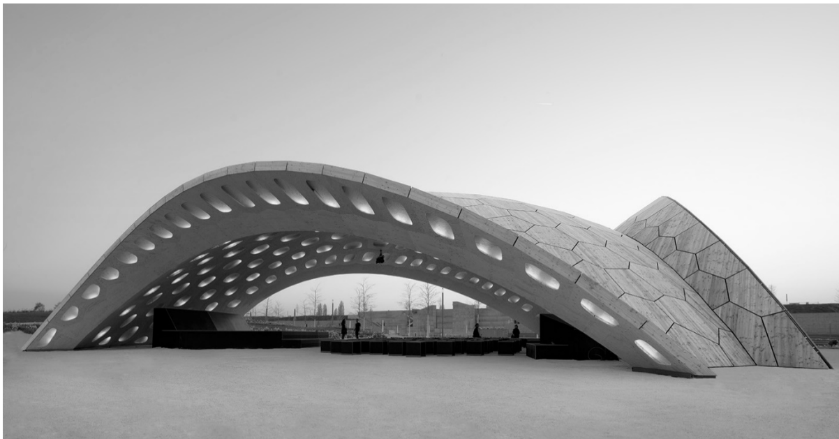
Figura 15. BUGA Wood Pavilion 2019 de ICD/ITKE University of Stuttgart, proyecto liderado por Achim Menges y construido (Heilbronn, 2019). Fuente: Menges, A. (2019). ICD/ITKE Research Pavilion 2019 [Imágen]. Recuperado de http://www.achimmenges.net/?p=20987 . Copyright [2019] © ICD/ITKE University of Stuttgart.
