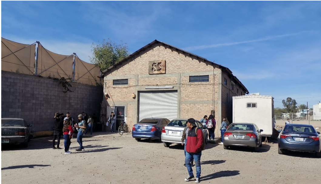
Figura 153. Imagen frontal de galerón a rehabilitar como casa estudio. Mexicali, Baja California, México.
