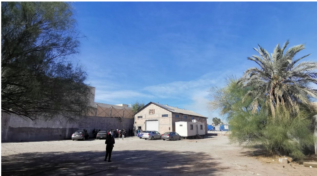
Figura 154. Imagen panorámica de galerón a rehabilitar como casa estudio. Mexicali, Baja California, México.
