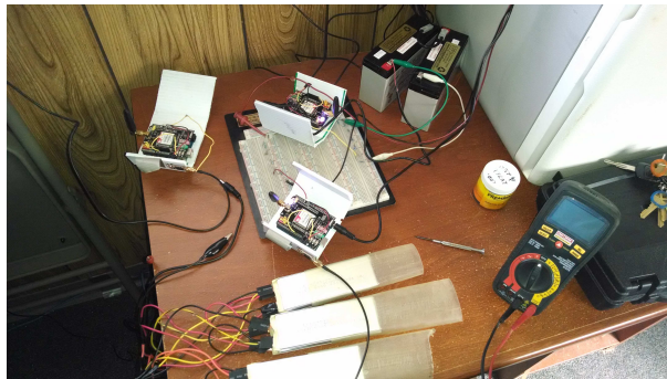
Figura 2.21: Prueba de efectividad de suministros de energía.
