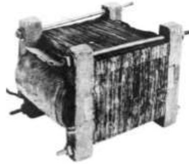
FIGURA 4: TRANSFORMADOR DE STANLEY MODIFICADO POR WESTINGHOUSE, SHALLENBERGER Y SCHMID [2]
