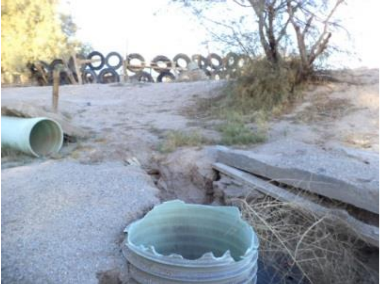
Imagen 20. El Pozo Coyote, abajo al centro, está el tubo clavado hacia el interior del agujero. Al fondo, los corrales que rodean al pozo. Fotografía: Vanessa Ruiz.
