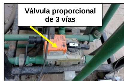
Figura 36. Componentes del subsistema de control.
