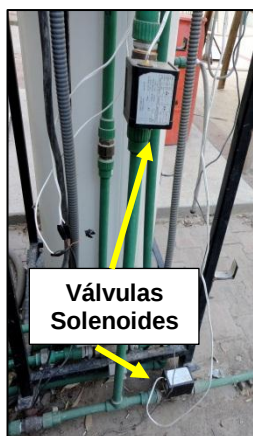
Figura 36. Componentes del subsistema de control.
