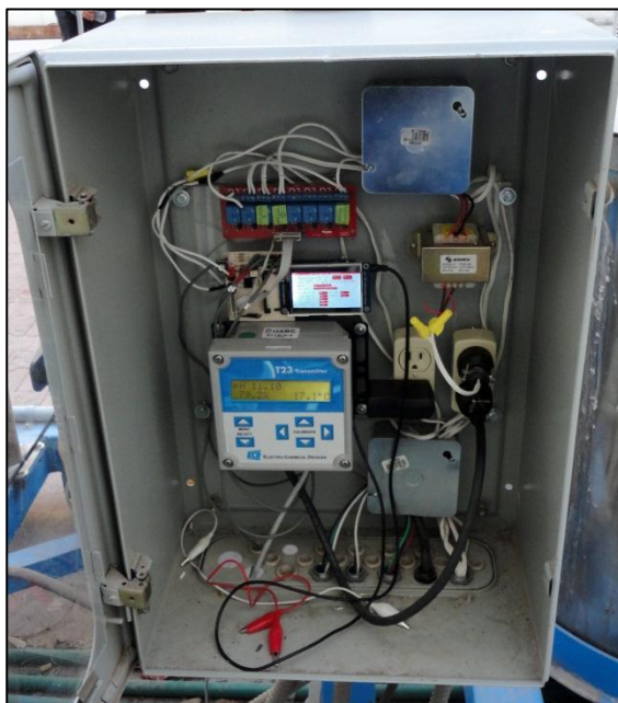
Figura 35. Subsistema de control.
