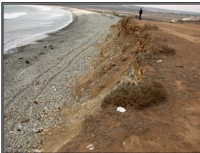
Figura 20. Cantil en a la Zona Norte (San Rafael) en donde se aprecia que la cresta tienen poca vegetación natural.
