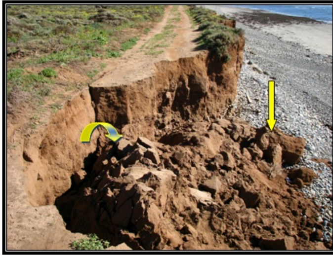
Figura 8. Cantil de San Rafael entre el punto de muestreo (10 y 11), la flecha curvada indica el derrumbe y la flecha vertical indica el bloque ya colapsado
