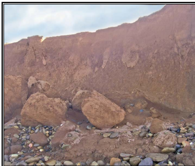
Figura 24. Bloques derrumbados después de una tormenta, Zona de Punta San Telmo.
