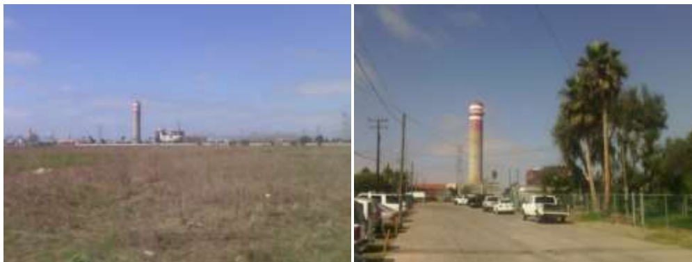
Figura 3.14. (a) y (b) Parte oeste vista hacia el este de la planta.
