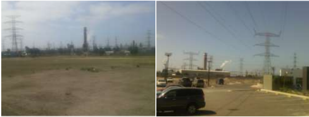
Figura 3.13. (a) Parte este vista hacia el oeste de la planta, (b) Parte norte vista hacia el sur de la planta.
