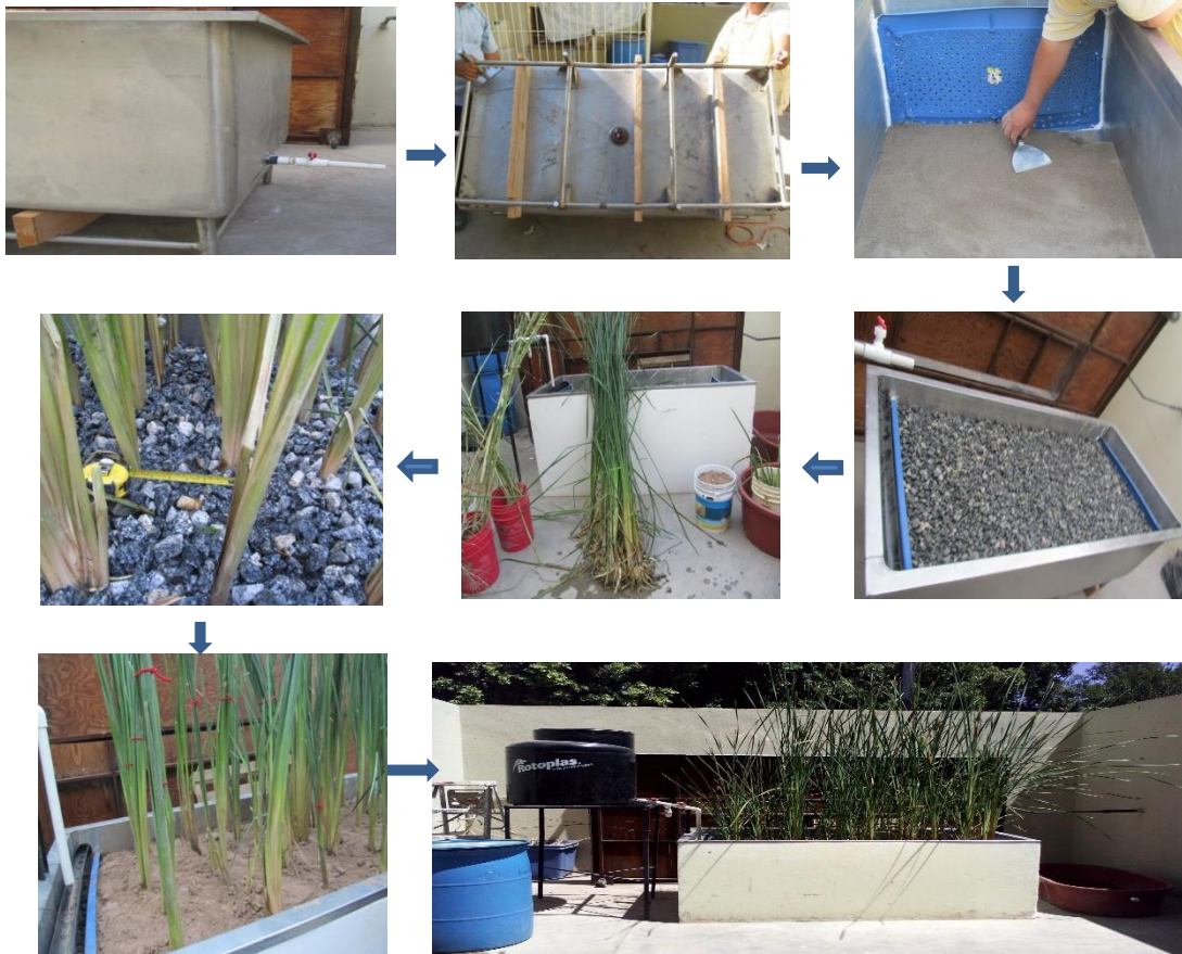
Figura 17. Procedimiento de construcción del HAFSS-H
