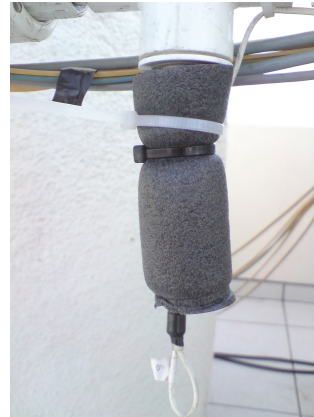
(b) Instalación sensor de temperatura RTD.
