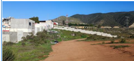
E. Vertedero y muros en C-B
