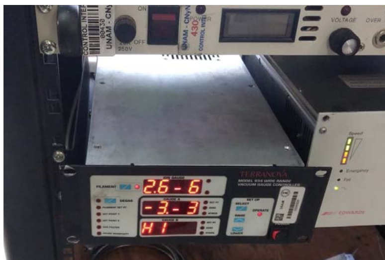
Figura 14.- Valor de vacío alcanzado en prueba de vacío final
