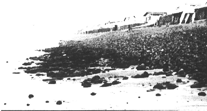
Foto 3. Banco de Nivel 3 (Marzo 1998) Arena parcialmente removida y reemplazada por canto rodado
