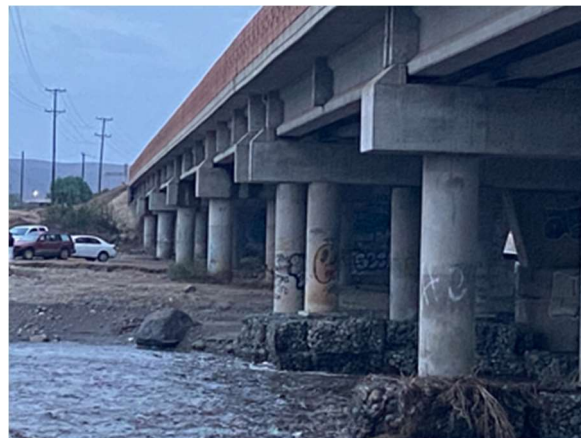
Figura 155: Vista lateral del puente, mostrando un eje de marcos dobles con una columna rectangular
