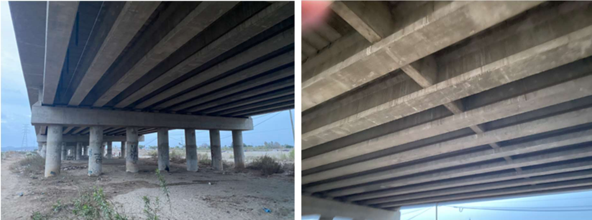
Figura 154: Vista de la superestructura, incluyendo vigas principales y soportes laterales
