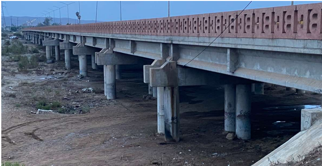
Figura 3: Puente Santo Domingo, vista lateral
