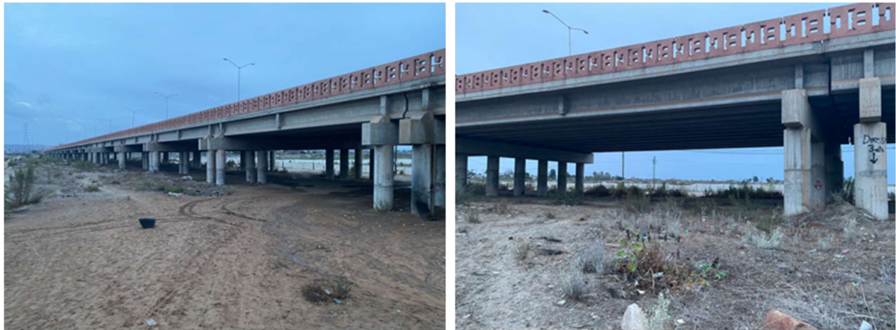
Figura 152: Vista lateral de los marcos dobles y sencillos del puente
