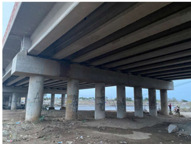
Figura 153: Vista isométrica de los marcos simples en los claros centrales del puente
