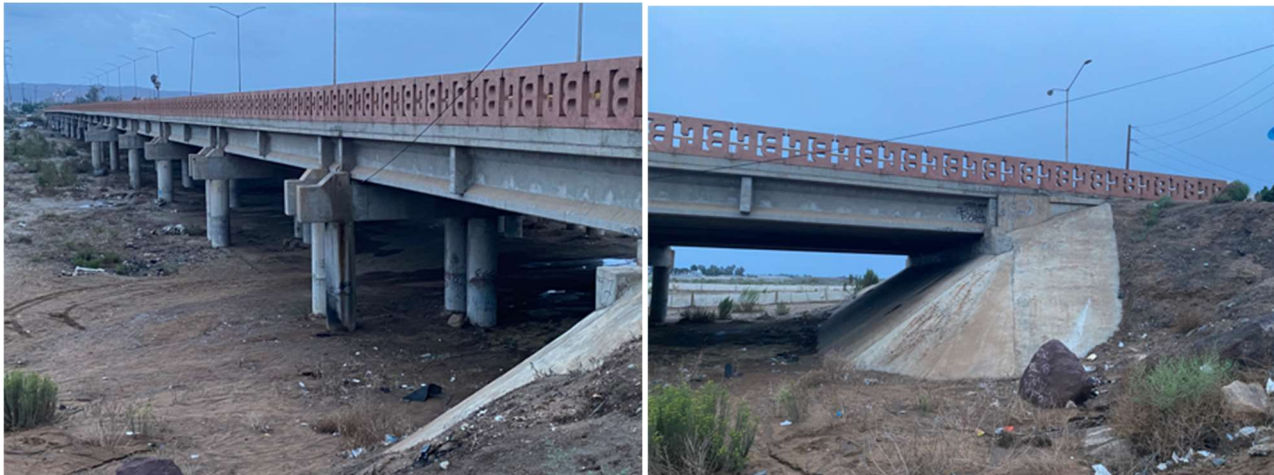
Figura 150: Estribo en los extremos y marcos dobles en los primeros claros del puente
