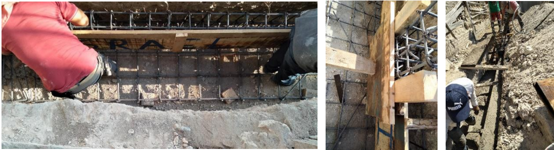
Figura 21. Armado de Zapata Corrida ZC-1 (Giovanni Sánchez).
