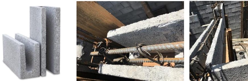
Figura 28. Bloque dala y armados en vanos de puertas y ventanas (fotografías propias).
