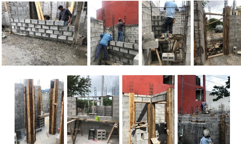
Figura 27. Desplante de muros interiores, armado, cimbrado y colado de castillos (fotografías propias).
