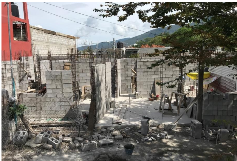
Figura 2. Sistema constructivo de mampostería confinada (fotografía propia).
