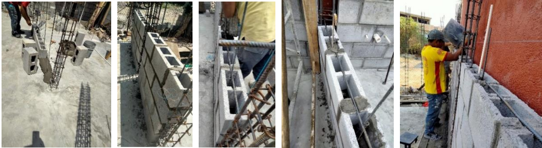
Figura 26. Desplante de muros interiores (Giovanni Sánchez).
