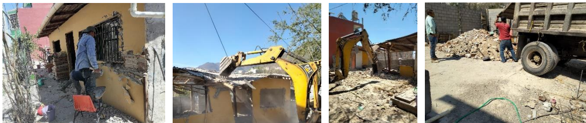
Figura 24. Demolición de vivienda anterior (Giovanni Sánchez).
