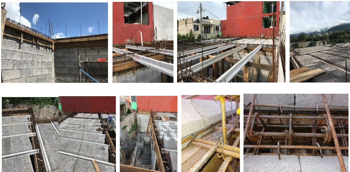
Figura 30. Cimbrado, colocación de viguetas y bovedillas, y armados de piezas especiales para recibir bovedillas (fotografías propias).
