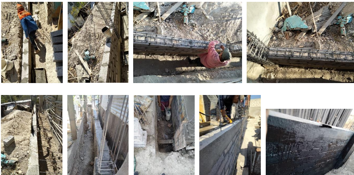
Figura 22. Renivelación de cimentación (Giovanni Sánchez).
