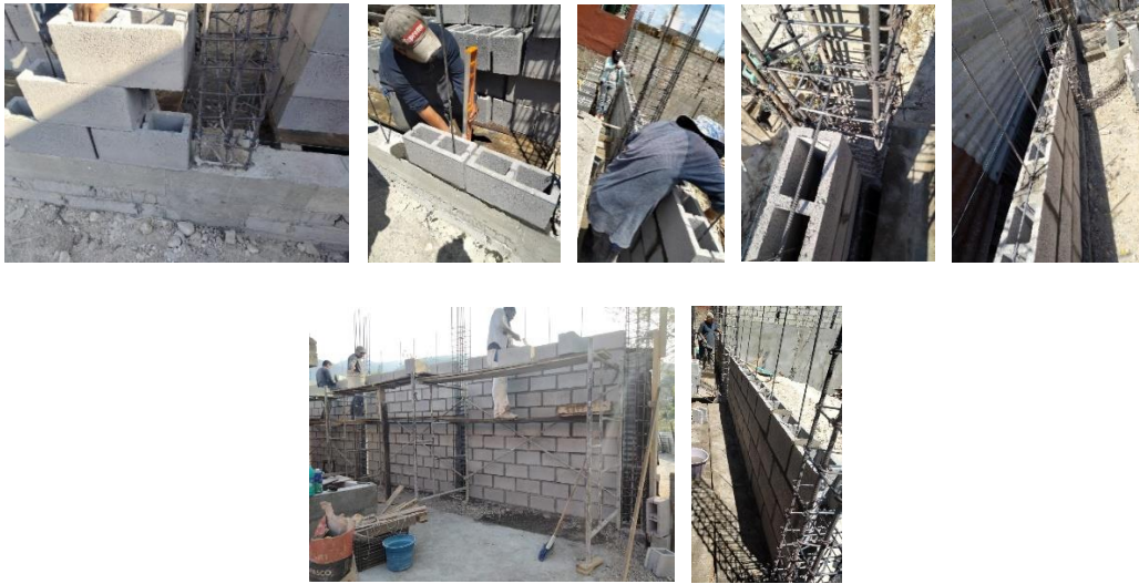
Figura 23. Desplante de muro a base de block hueco de 0.15x0.20x0.40 m (Giovanni Sánchez).
