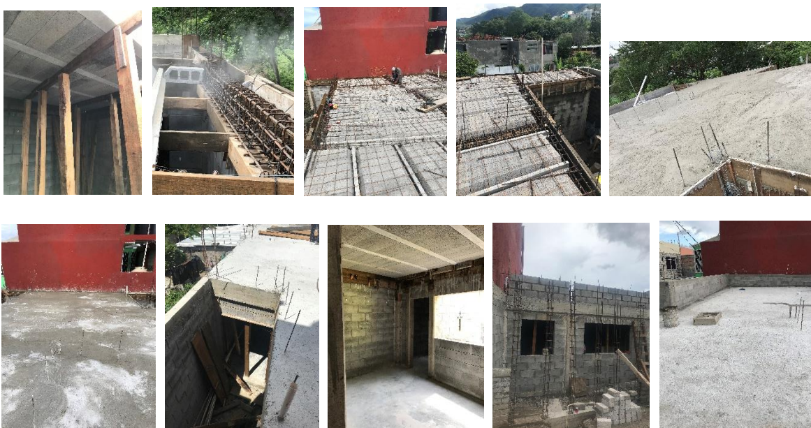
Figura 31. Proceso de construcción de la losa de azotea y pretil (fotografías propias).
