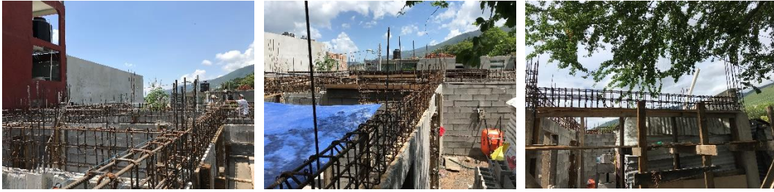
Figura 29. Armado de trabes y cerramientos para recibir losa (fotografías propias).
