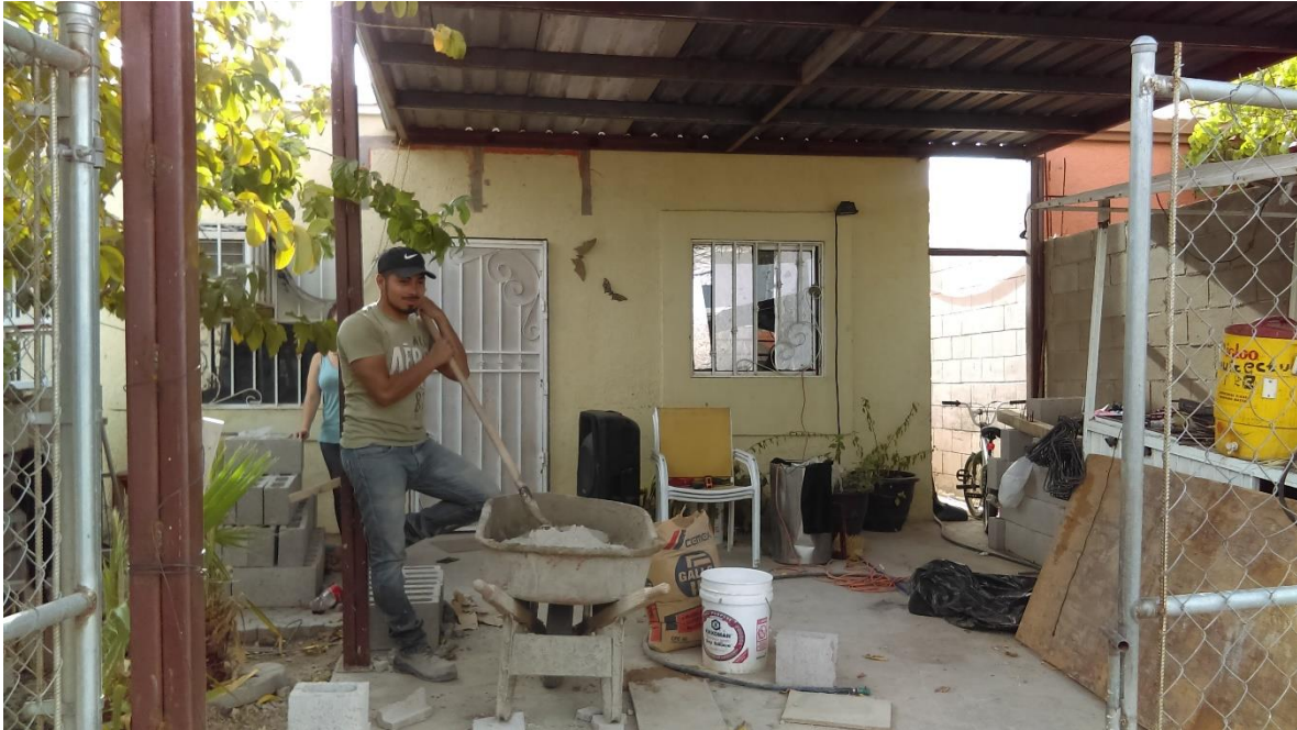
Construcción de barda en una avenida de Villa Lomas Altas II (archivo personal, noviembre 2016).
