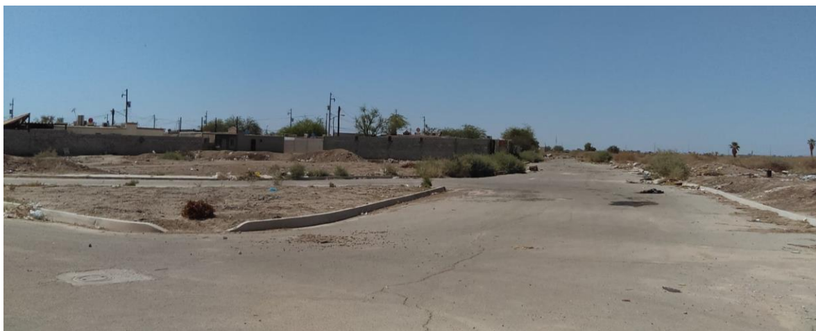
Vialidad y zona destinada a jardín, hacia el límite este de Villa Las Lomas, en estado de abandono (archivo personal, mayo 2018).
