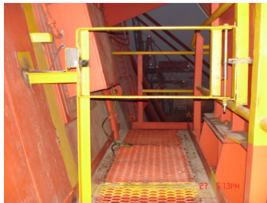
Figura 23. Puerta de acceso al Trolley.
