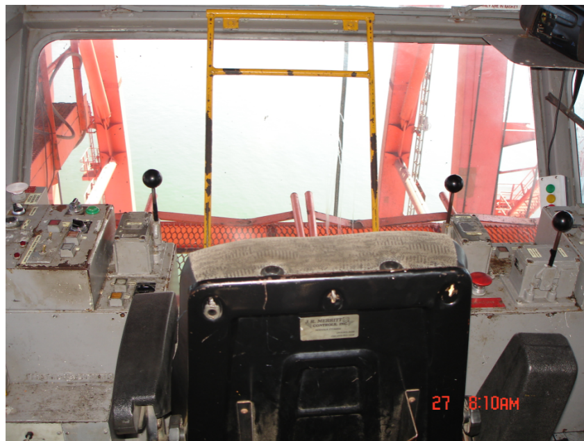
Figura 4. Cabina de operación vista desde adentro de la misma.
