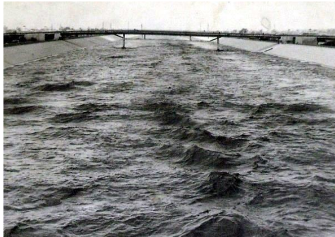
Fotografía tomada desde uno de los puentes que cruza la canalización del río Tijuana el cual muestra un gasto considerable debido a las altas precipitaciones presentadas. (Ayuntamiento de Tijuana, 2014b)
