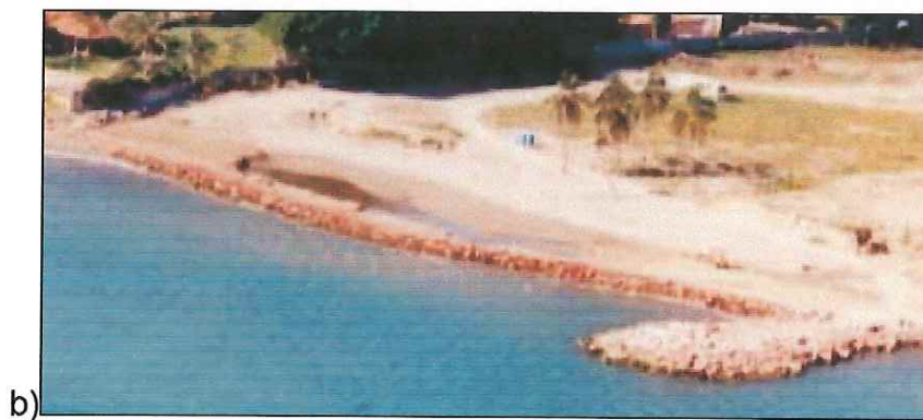
Figura-5. Playa en la parte central de Bahía de Banderas, al sur del área de estudio; a) con presencia de cantiles costeros (abril 2003) y b) cantiles removidos y construcción de enrocamiento (octubre 2003).
