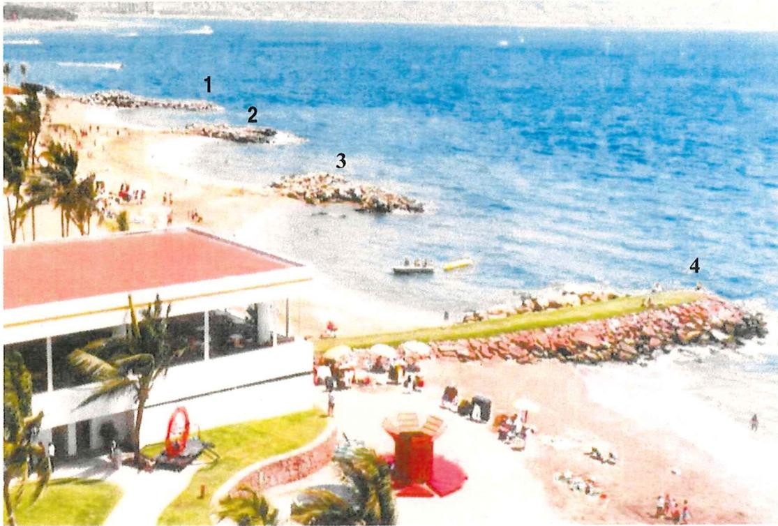
Figura 3. Playa 2, 1 Espión en construcción, 2 y 3 enrocamientos, 4 Espigón.
