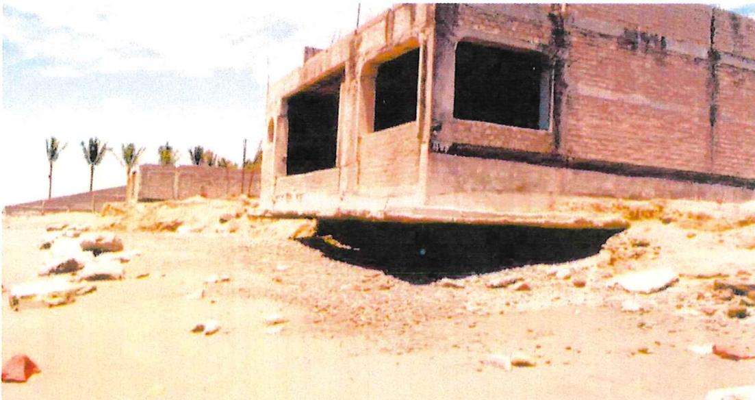
Figura 30. Construcción en obra negra dentro de la playa 1 que presenta erosión.
