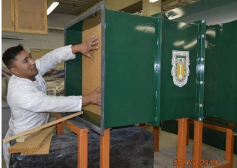
Figura 20. Instalación de honeycomb en cámara estabilizadora.
