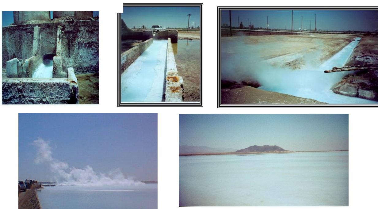
Imágenes 9.9 – 9.13 Residuos silíceo depositado en: a) canaletas, b) Laguna de Evaporación, c) Laguna de Inyección y c) Laguna con residuo de sílice y sales
