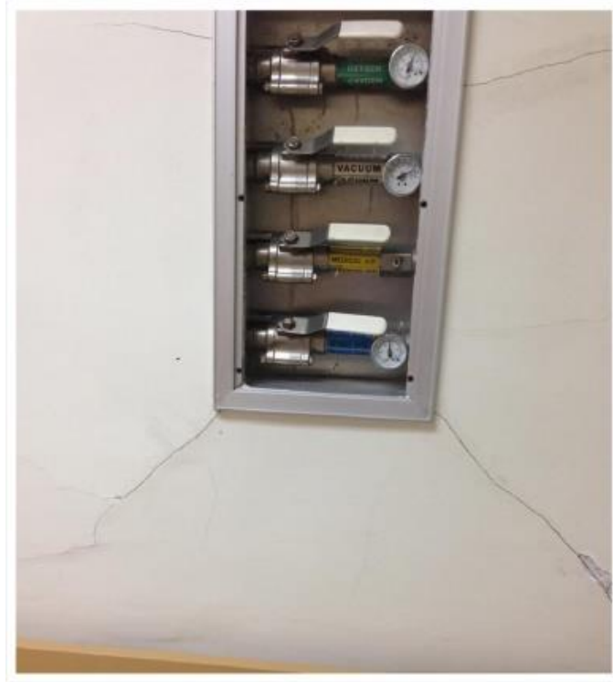
Figura 10. Llave de paso de gases
