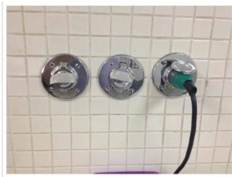
Figura 9. Toma de corrientes
