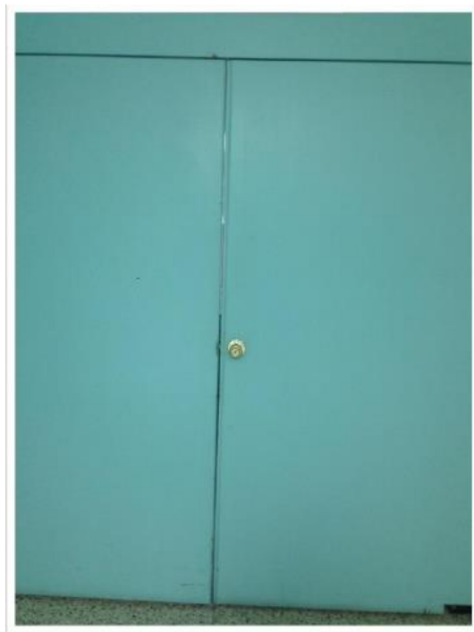
Figura 7. Acceso al área de quirófanos
