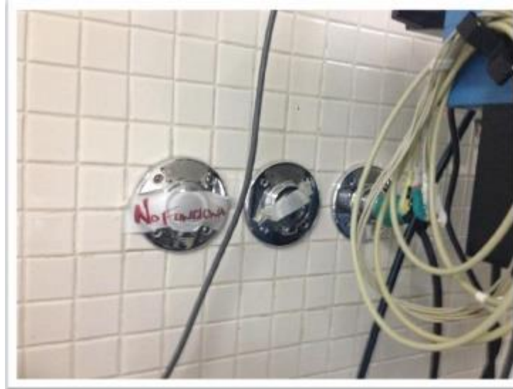
Figura 8. Toma de corrientes
