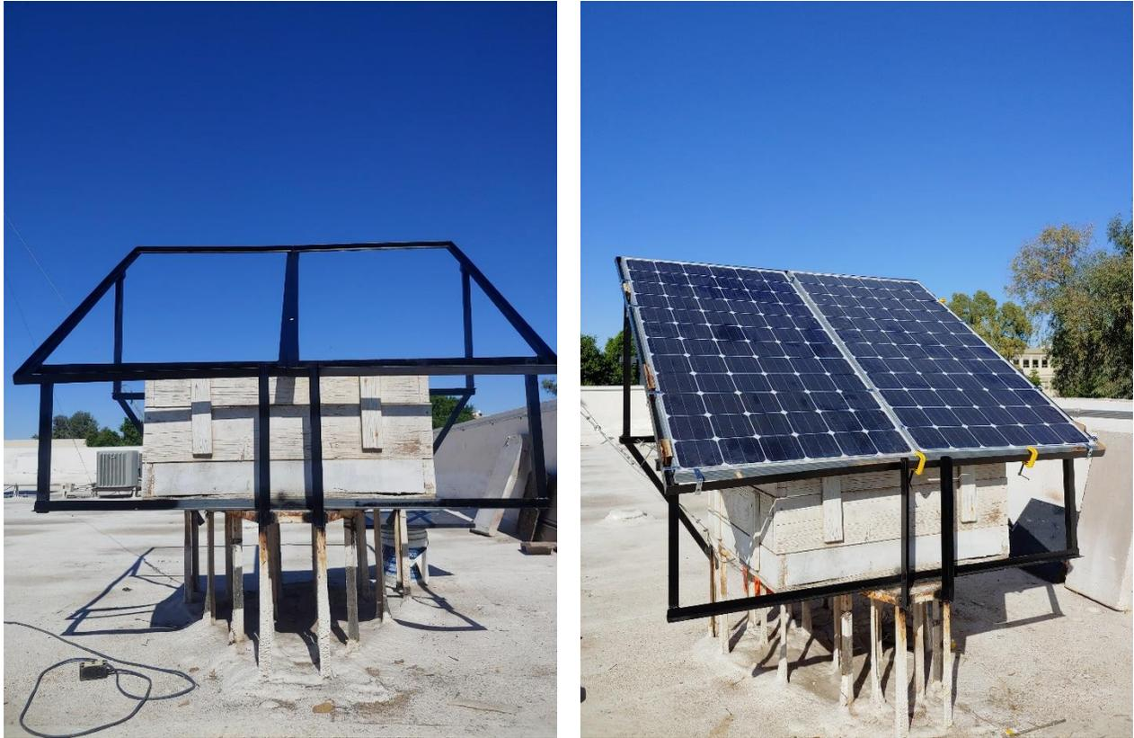
Figura 9. Estructura y base de sujeción para los paneles fotovoltaicos. A la izquierda se observa la estructura, a la derecha se muestra a los paneles ya instalados sobre la misma.
