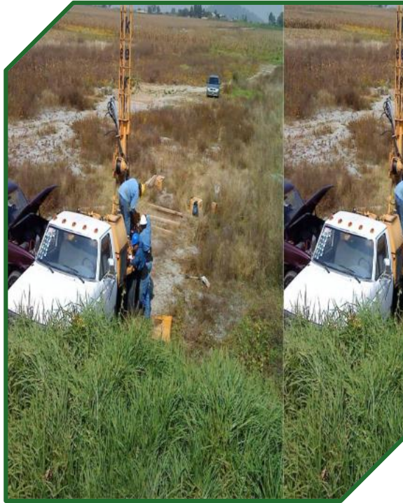
Figura 3.14. Perforadora Wacker de la Facultad de Ingeniería de la UAEMéx, realizando la perforación del piezómetro en San Mateo Mexicaltzingo.
