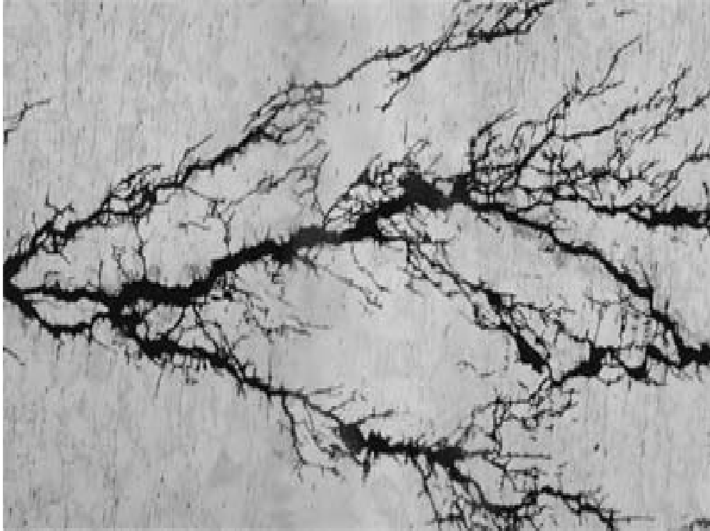
Figura 2.7. Corrosión por esfuerzo en acero al carbono con grietas ramificadas. Fuente. http://corrosion.ksc.nasa.gov/stresscor.htm
