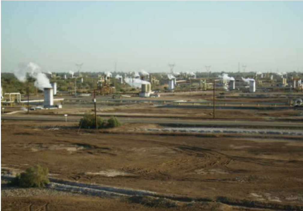
Figura 3.2. Pozos geotérmicos de la planta geotérmica Cerro Prieto.
