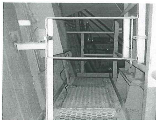
Figura 23. Puerta de acceso al Trolley.
