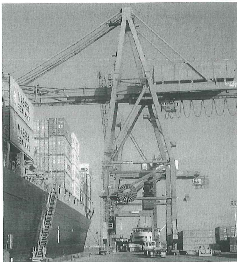
Figura 1. Grúa pórtico en operación en el muelle de Ensenada.
