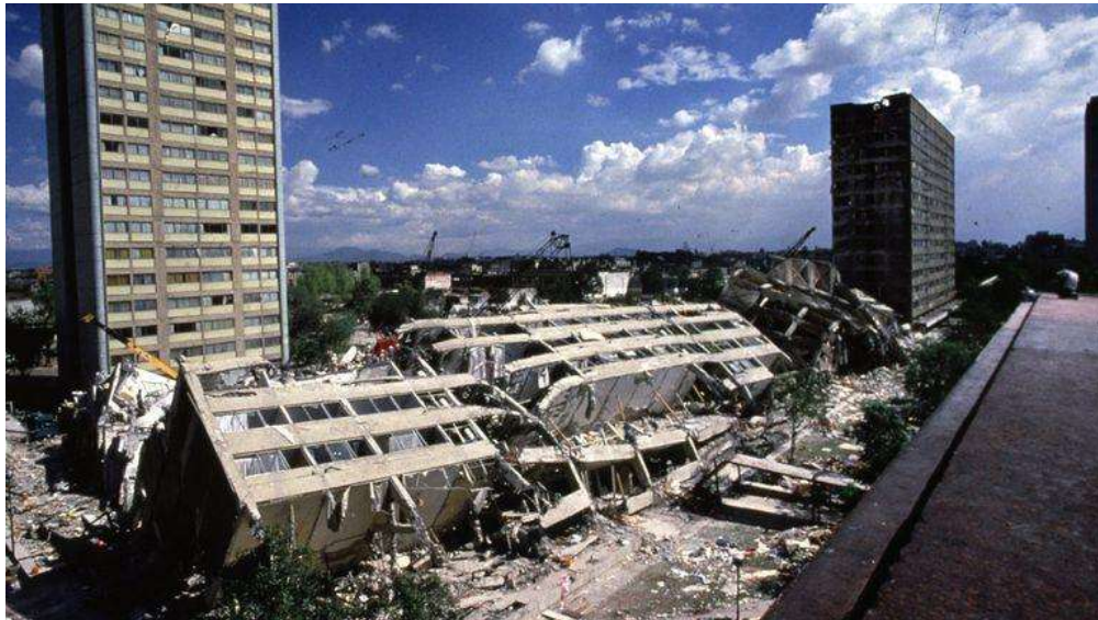
Figura 1.1 Edificio colapsado después del terremoto de 1985. (La Nación, 2017)
