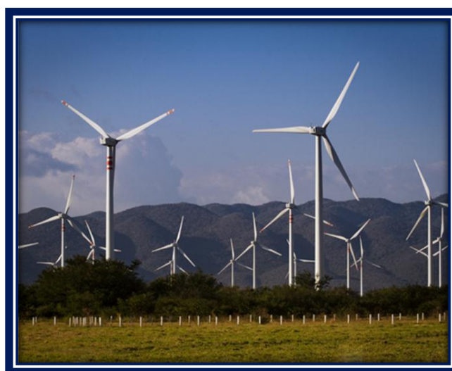
Fig. 12 Parque eólico Oaxaca II, Acciona, (2016).
