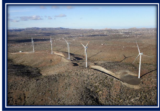
Fig. 7 Parque eólico La Rumorosa (Comisión Estatal de Energía del Estado de Baja California, 2020).
