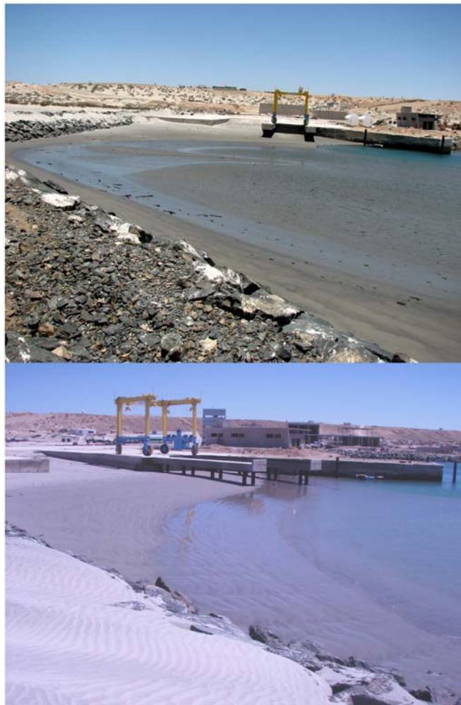
**Figura 1.** Fotografías del estado actual de la marina en Santa Rosalita, B. C. En ambas imágenes se observa el impacto causado (interior de la dársena y sección del rompeolas) por el transporte eólico proveniente del campo de dunas aledaño (fotografías de Guillermo E. Ávila Serrano).
