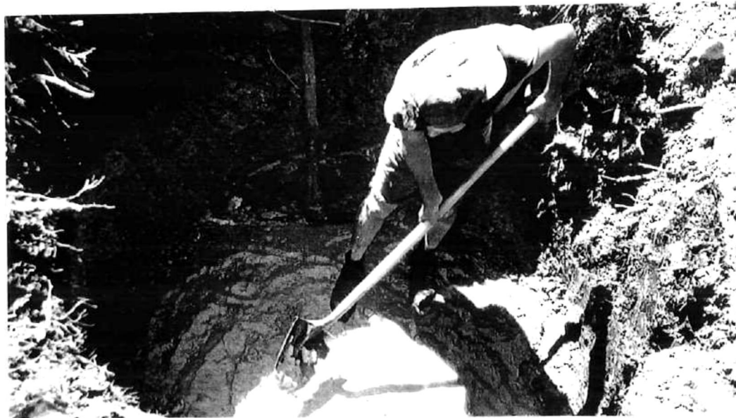
Fotografía 14.- Cavado para insertar la forma.
