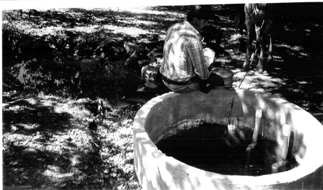
Fotografía 16.- Forma con sifón para la conducción del agua.
