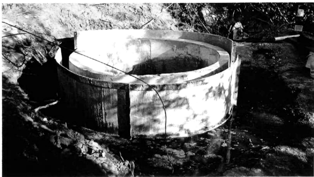
Fotografía 15.- Forma para la captación y filtrado del agua.
