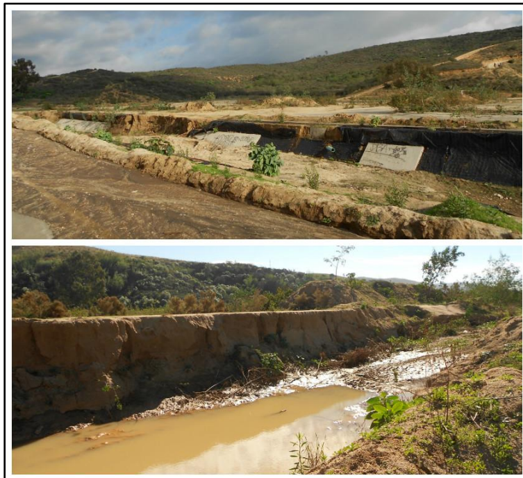
Fig. 3.12 Obra de colector de aguas negras sin terminar
