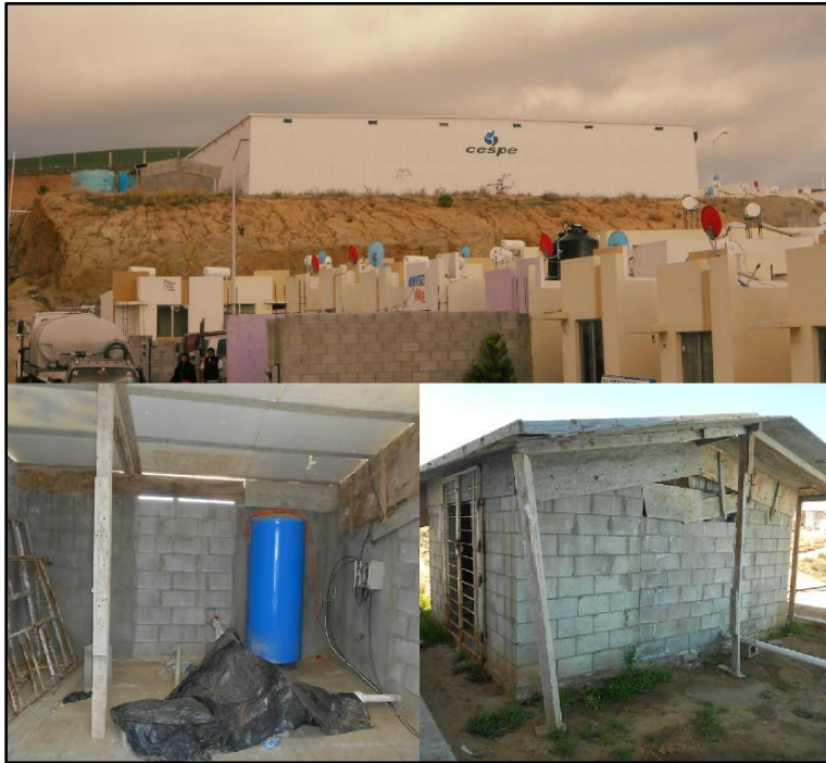
Fig. 3.11 Obras de tanque de almacenamiento sin terminar
